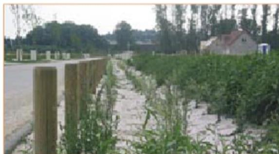
Une noue collectrice des eaux pluviales.
