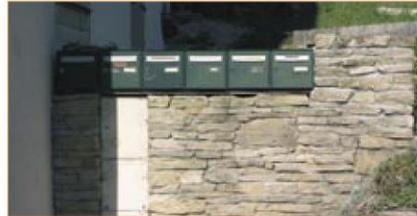
Boîtes aux lettres et coffrets de réseaux peuvent être intégrés aux murets ou à des éléments de clôture.
